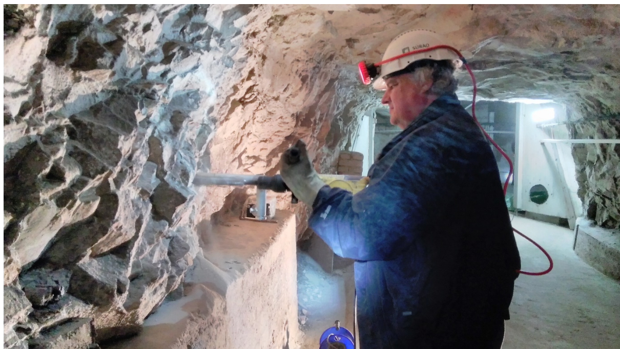
Obr. 11. Instalace přístroje TM-71 (bývalá podzemní továrna Richard)
