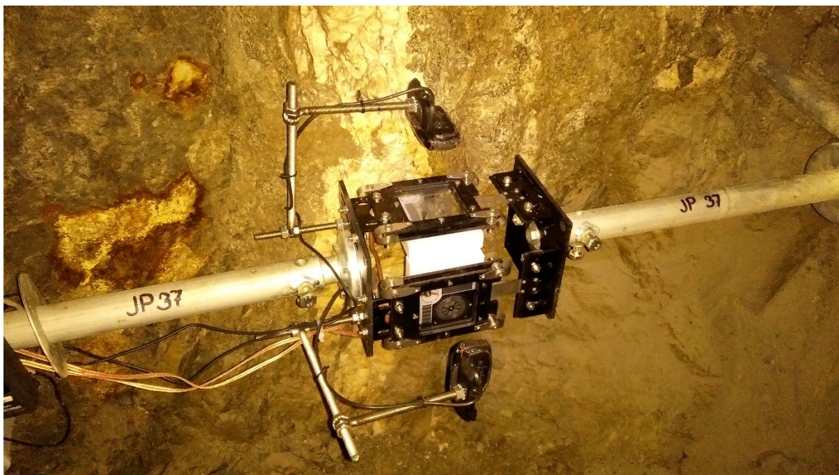
Obr. 7. Nainstalovaný přístroj TM-71 (rovrážka JP37, štola Josef, přístroj JOS2)
