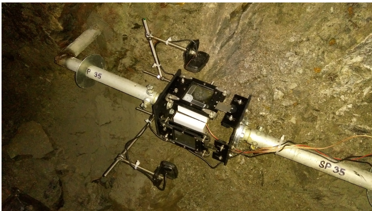
Obr. 6. Instalovaný 3D dilatometr TM-71 na lokalitě Josef s automatickým odečtem (JOS3).
