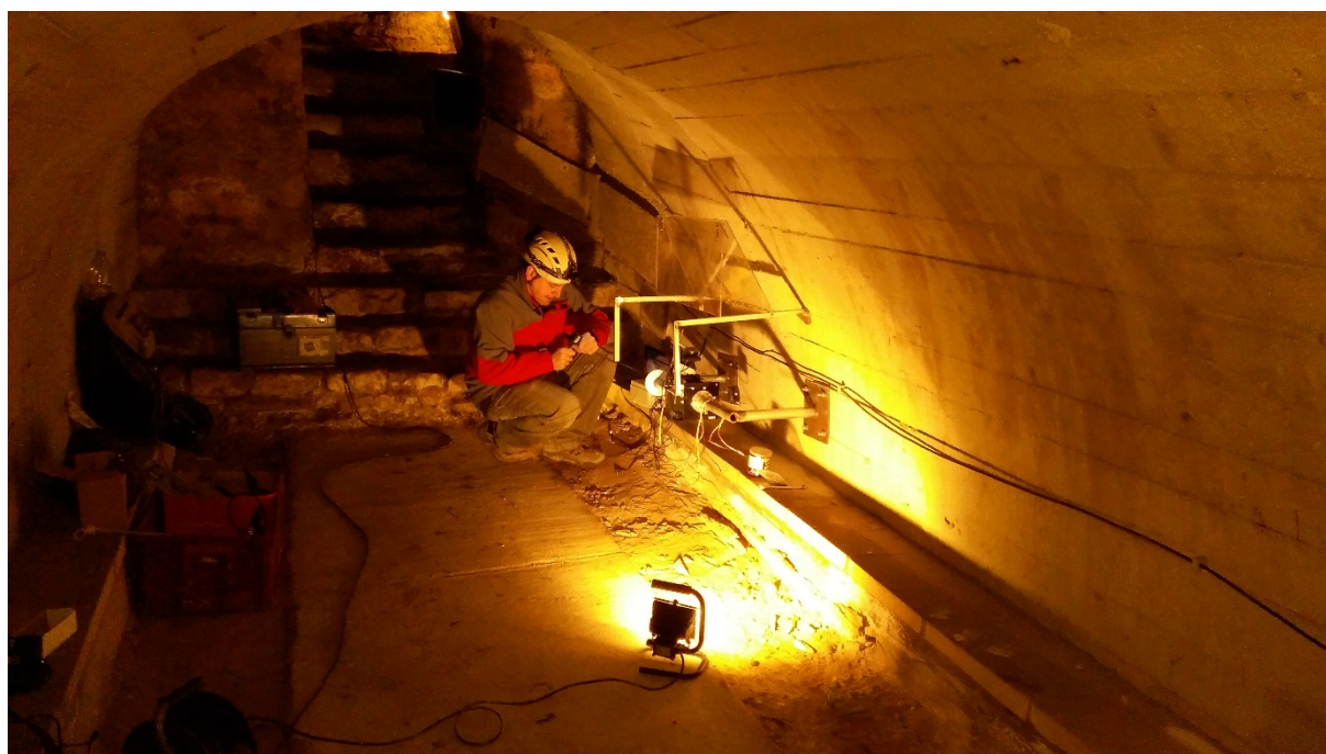
Obr. 8. Instalace přístroje TM-71 (podzemí Litoměřic)
